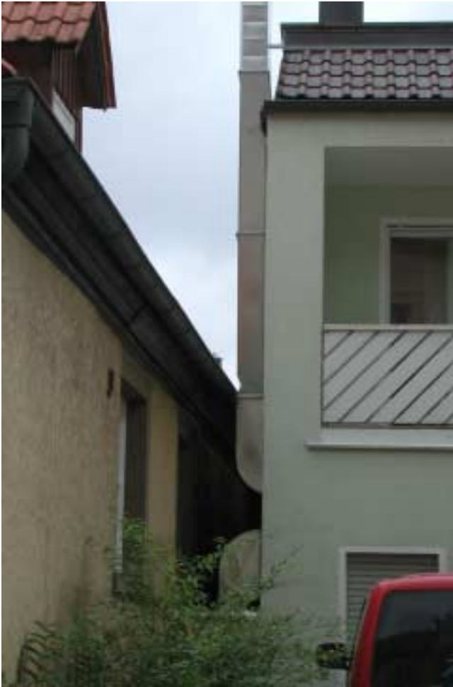
Enge Platzverhältnisse auch außerhalb des Baukörpers.
